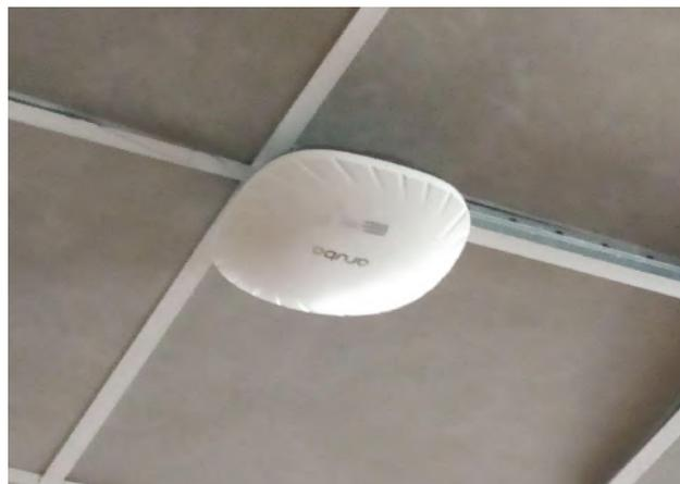
Pour la connexion, j'ai utilisé les prises déjà utilisées par les anciennes bornes. Étant reliées à un switch POE, il ne faut qu'un câble RJ45 pour la connexion au réseau Ethernet et électrique.
